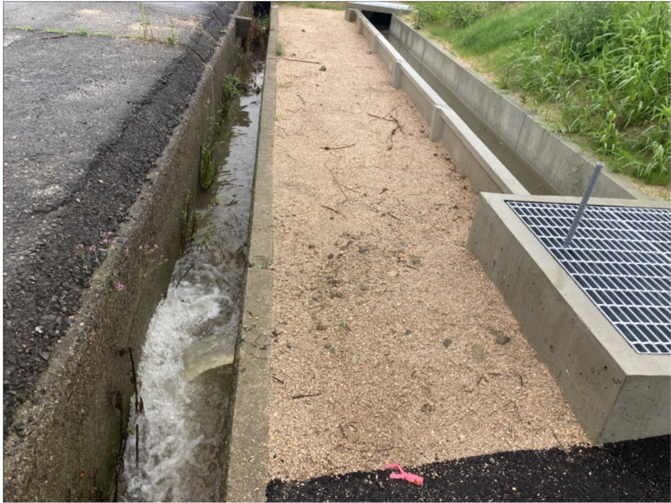
撮影日 2025-06-14 04:56:37 コメント 縄手地区事業用地付近 この部分の真横に新設国道2号が通る 工事に合わせて600幅の排水ゲートを設置するよう段取りを進めている 排水は上後山暗渠水路を通じて長通水路へ流す予定 今は用水用として200φの給水パイプを設置している
