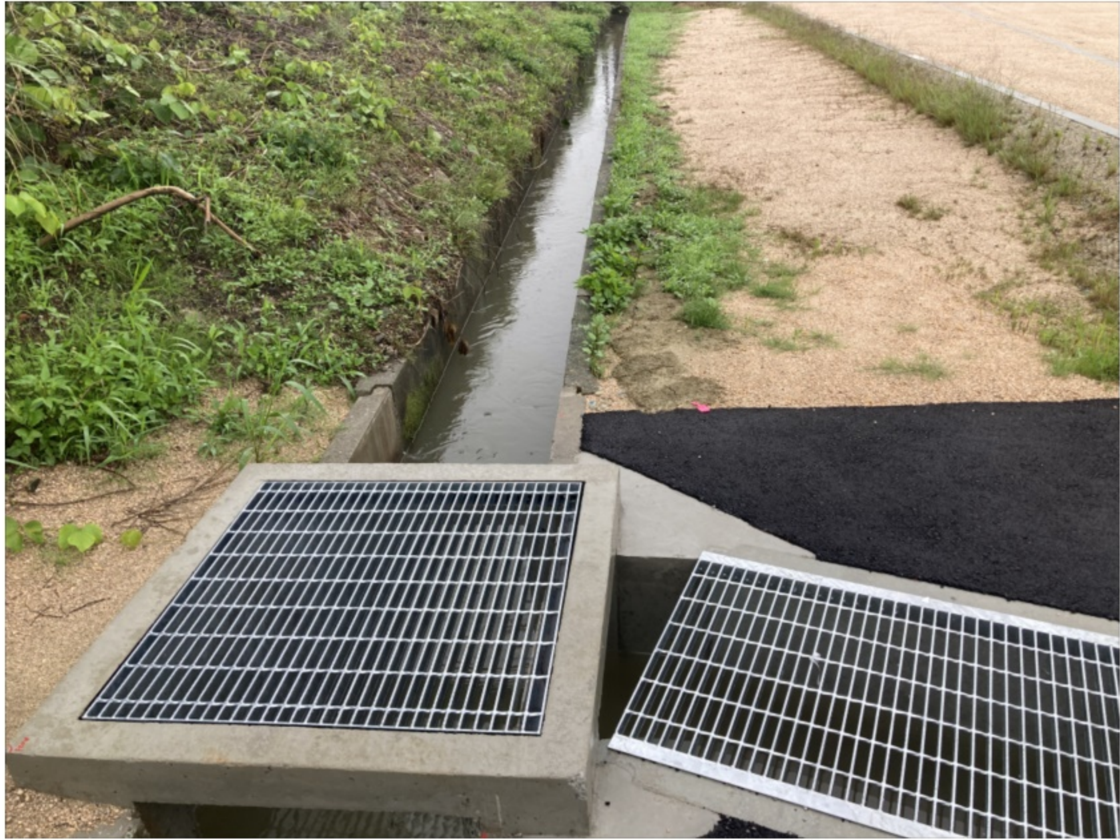
撮影日 2025-06-13 06:40:15 コメント 縄手地区事業用地新規大村樋水路の状況 向こうが道の上へ向かう従来の水路、右が長沢池側の新水路
